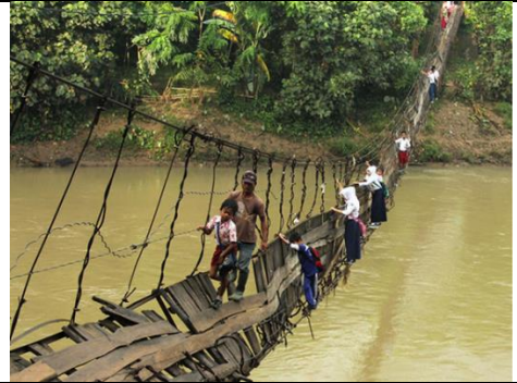
Μαθητές στην Ινδονησία, περνούν από κατεστραμμένη γέφυρα
